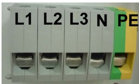
Illustration 17 : raccordement au réseau
