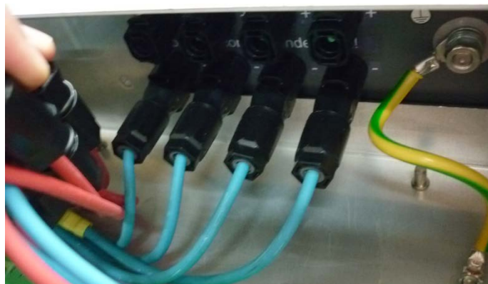
Bild 31: Sunclix-Steckverbindungen herstellen
